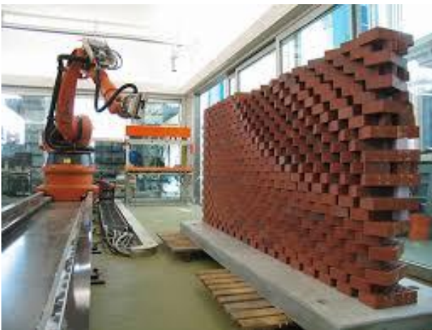
Gambar 2. 11. Robot pemasang batu bata
