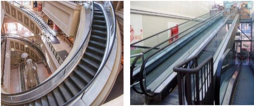
Gambar 6. 16. Teknologi Eskalator Spiral dan Travelator
