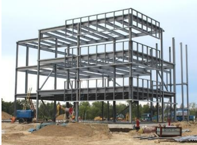
Gambar 4. 3. Struktur Rangka dengan bahan baja
