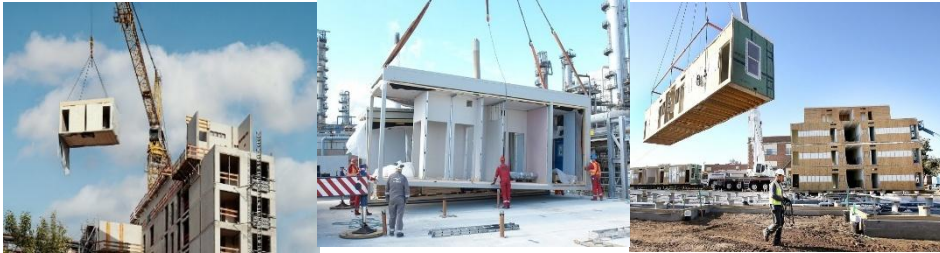
Gambar 8. 3. Proses perakitan produk prefab di Lokasi
