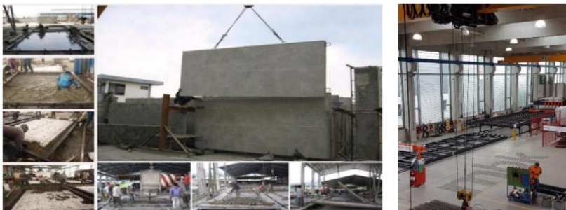
Gambar 8. 2. Proses pembuatan komponen modular prefabrikasi beton
