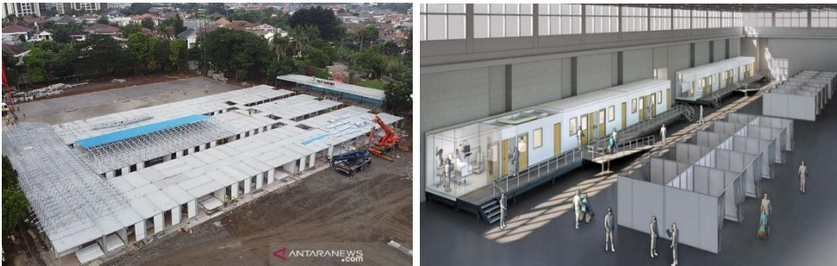
Gambar 8. 8. Proses pembangunan RS Pusat Pertamina Jakarta Selatan
