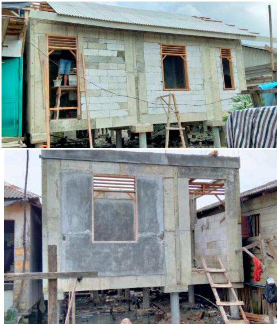
Gambar 3: Pembangunan RUSPIN di Kawasan Belawan Bahari (Balai P2P Sumatera II, 2022)
