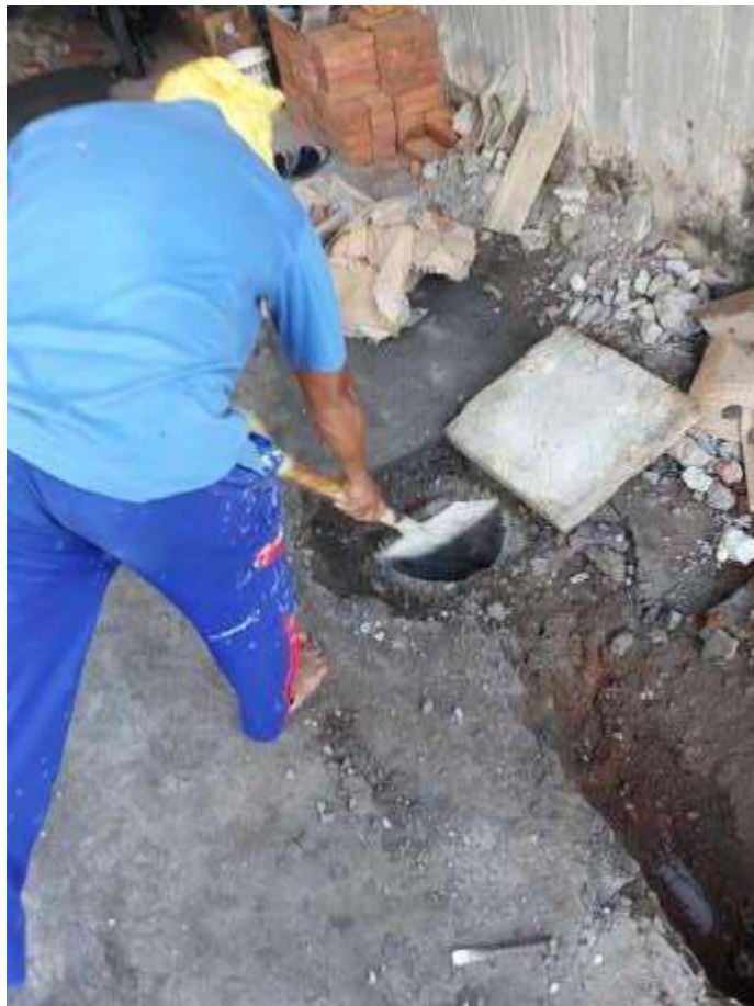
Gambar 8: Buist Beton Diisi Kerikil dan Pasir Sebagai Penyaring air Menuju Tanah (Sumber: Dokumentasi Pribadi)
