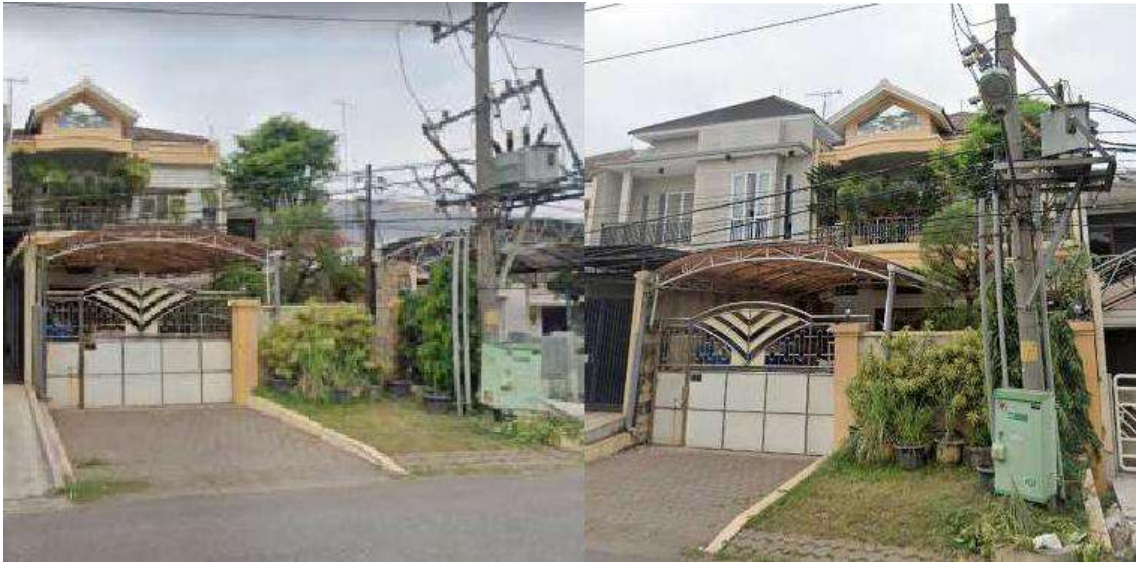
Gambar 3: Rumah Jalan Kalimas Barat(Sumber: Dokumentasi Pribadi)
